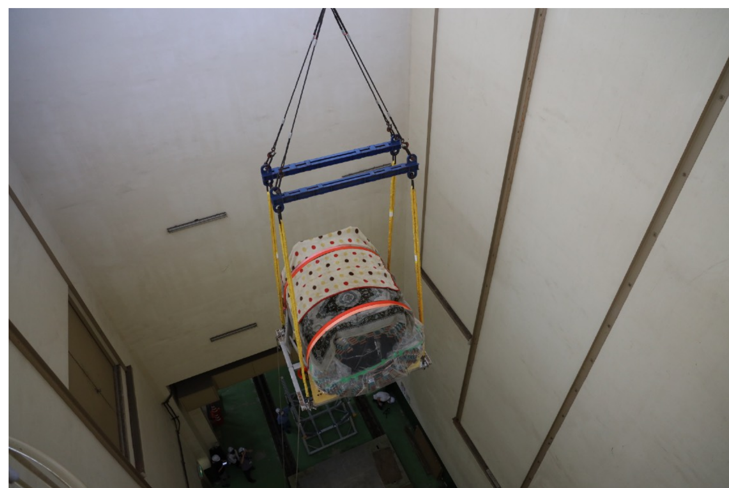
地上への吊り上げ(縦坑シャフト)
